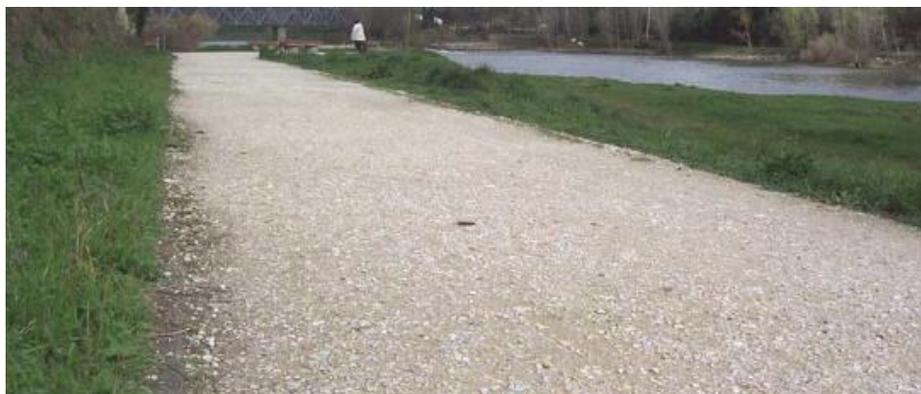
**Foto 4 – Piste ciclabili – Pavimentazione in stabilizzato di cava**
