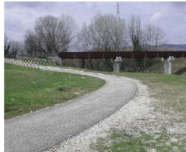
Foto 1 – Piste ciclabili – Pavimentazione in rifinita in emulsione bituminosa
