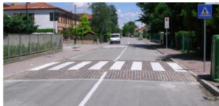
Foto 6 – Isole Ambientali – Esempio di piattaforma rialzata (Mestre)
