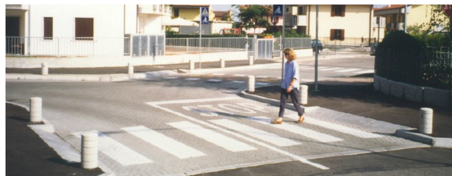
Foto 5 – Isole Ambientali – Esempio di attraversamento pedonale con restringimento
