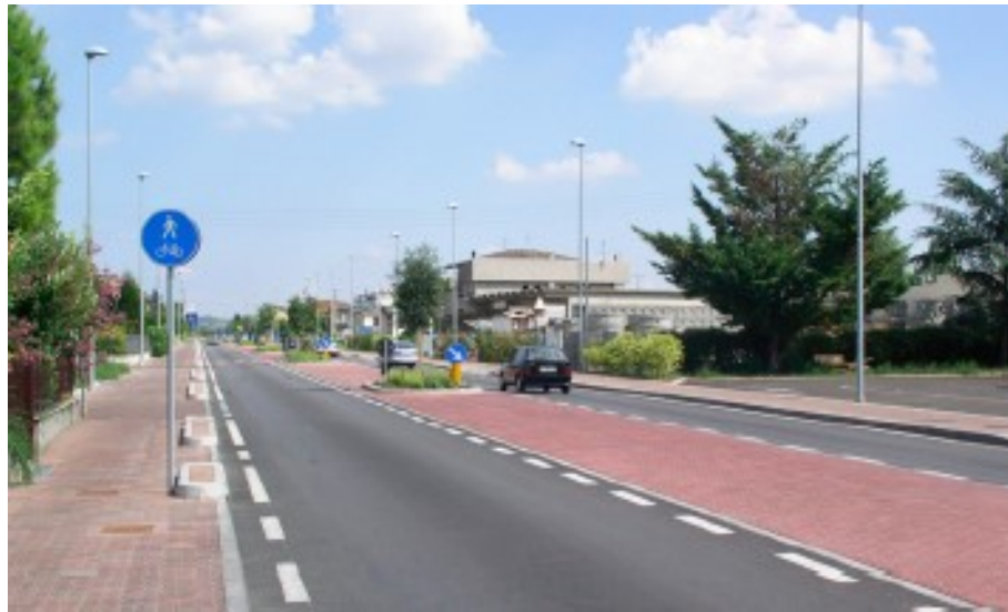
Foto 2 – Spartitraffico centrale sormontabile
