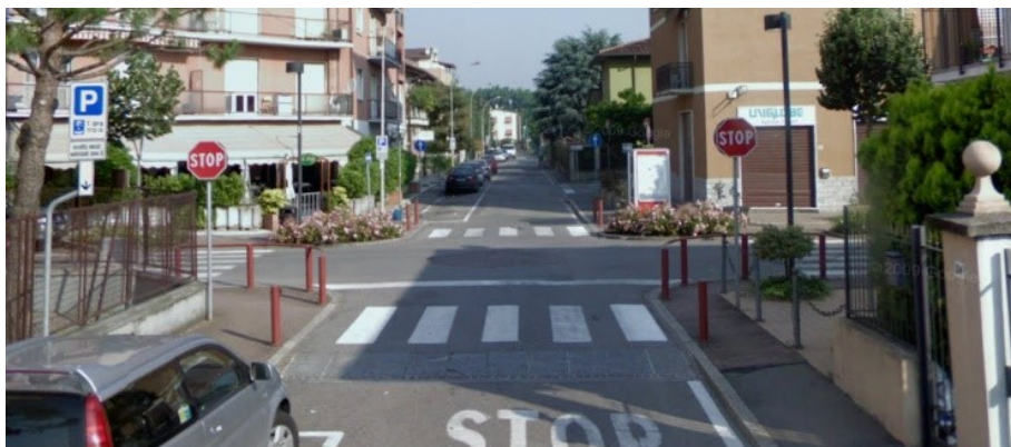
Foto 8 – Isole Ambientali – Avanzamento marciapiede alle intersezioni (Arcore)
