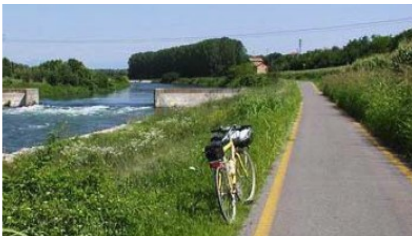
Foto 20 – Piste ciclabili – Pavimentazione in asfalto ecologico
