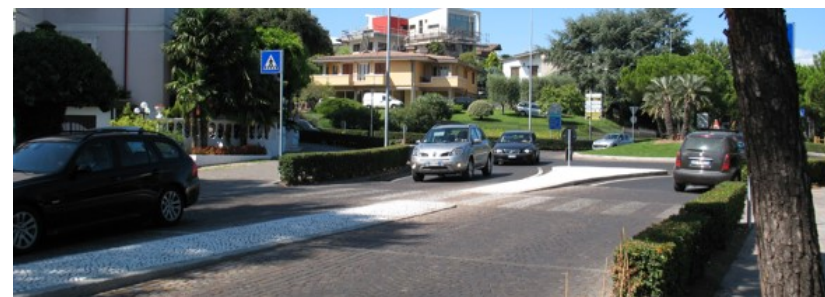
Foto 15 – Isole Ambientali – Attraversamento con piattaforma rialzata (Desenzano)
