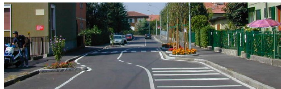
Foto 10 – Isole Ambientali – Chicane realizzata con sosta e marciapiede (Cassano)
