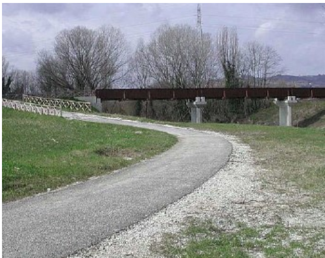
Foto 19 – Piste ciclabili – Pavimentazione in rifinita in emulsione bituminosa
