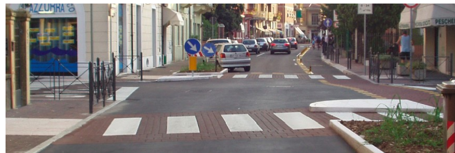
Foto 9 – Isole Ambientali – Chicane realizzata con sosta e marciapiede (Verona)
