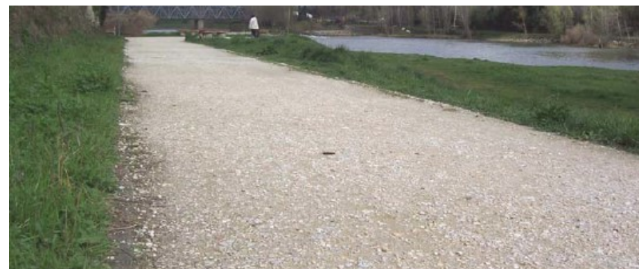
Foto 22 – Piste ciclabili – Pavimentazione in stabilizzato di cava
