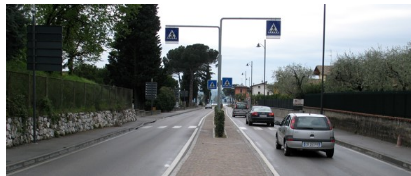
Foto 14 – Isole Ambientali – Attraversamento con isola spartitraffico (Desenzano)
