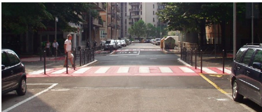
Foto 7 – Isole Ambientali – Avanzamento marciapiede alle intersezioni (Verona)
