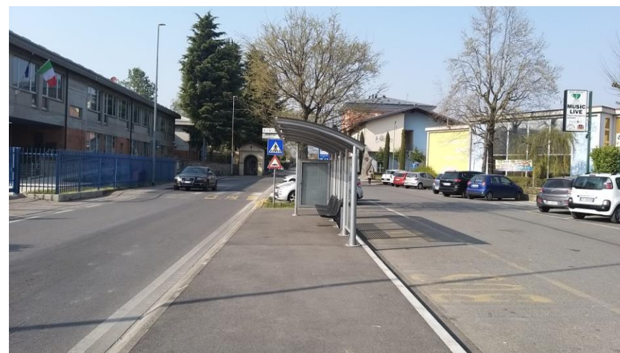
Figura 53 – Fermata in carreggiata con pensilina – via San Francesco D'Assisi
