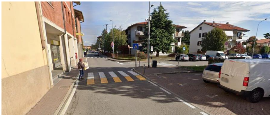
Figura 32 – Intersezione con piattaforma stradale rialzata – via San Rocco / via Aldo Moro
