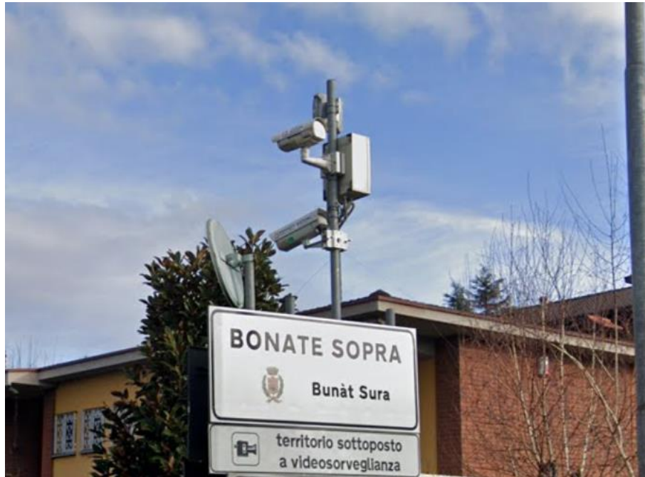
Figura 84 – Esempio di videocamere installate sul territorio comunale
