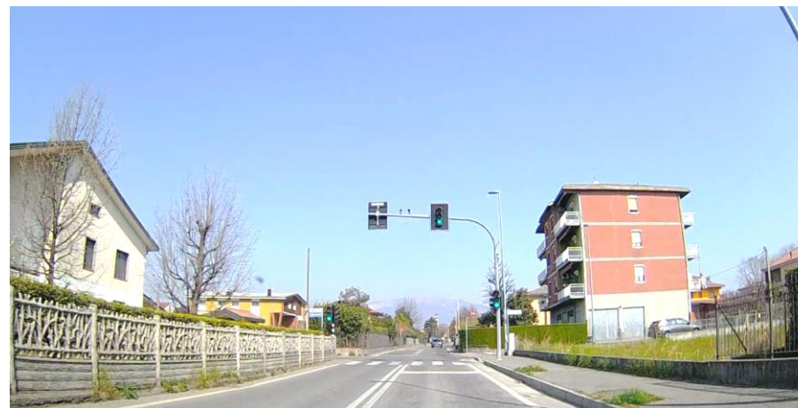
Figura 28 – Impianto semaforico pedonale lungo via Trieste
