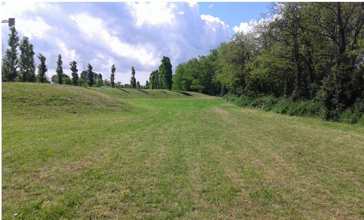
Figura 3: Rilevati a difesa delle piene del torrente Dordo
